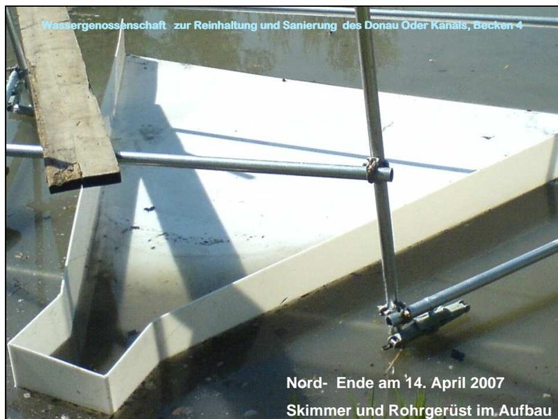
Die Absauganlagen an beiden Enden des DOK IV wurden mit neuen Absaugflächen (Skimmern) ausgestattet. Die am 12. April 2007 gelieferten Skimmer, sind höhenverstellbar in einem Rohrgerüst montiert.
